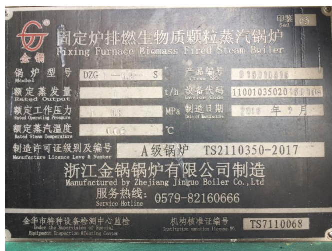
图 2-3 生物质锅炉铭牌参数
